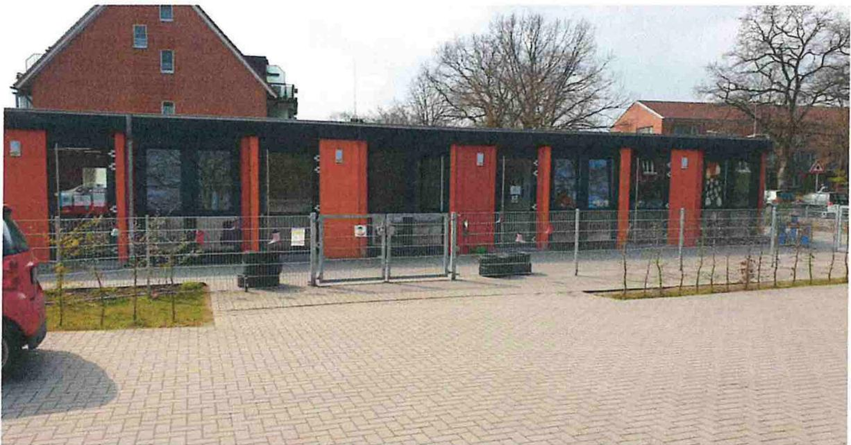
Die Kita (siehe Bild oben) ist in Containerbauweise errichtet, so dass ein externes Gerüst die Anlage tragen kann und die Statik der Container nicht geprüft zu werden braucht.
