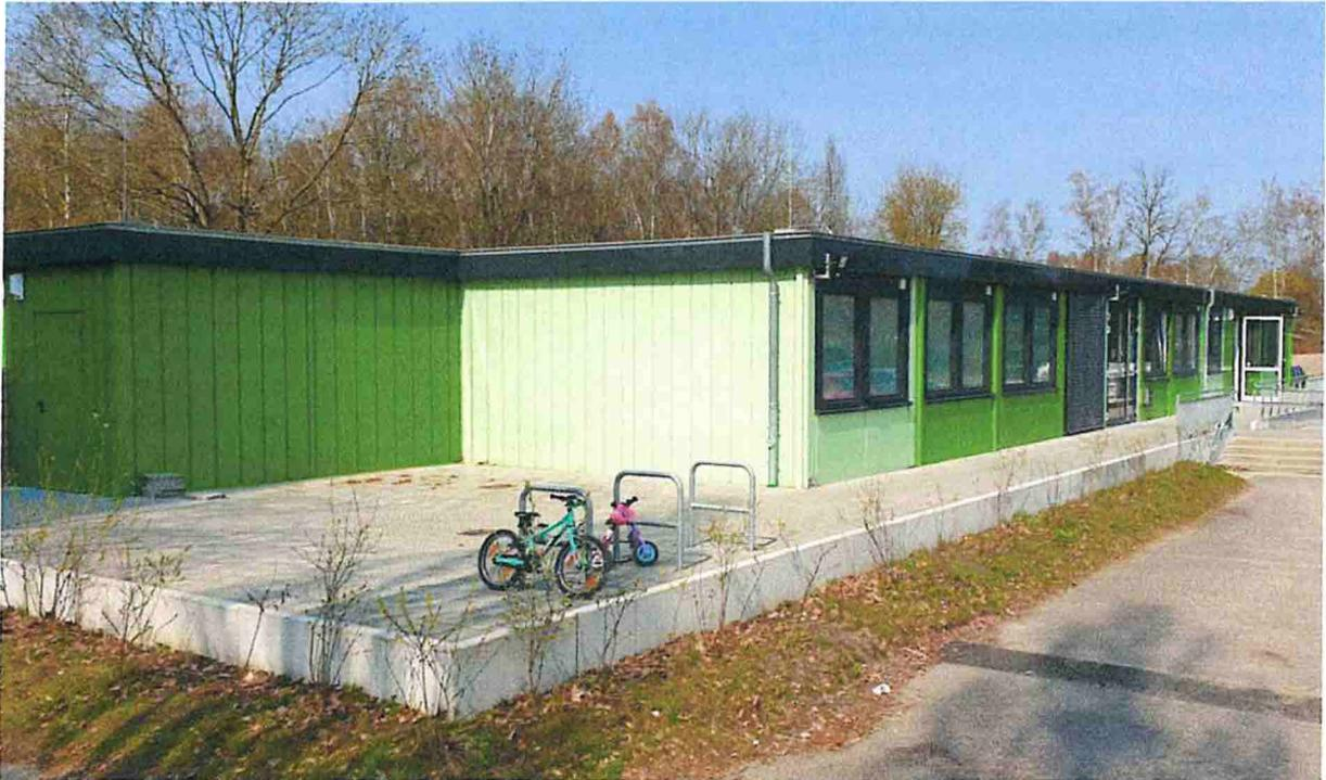
Die Kita (siehe Bild oben) ist in Containerbauweise errichtet, so dass ein externes Gerüst die Anlage tragen kann und die Statik der Container nicht geprüft zu werden braucht.
