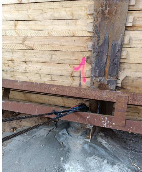
Die Arbeiten schreiten planmäßig voran. Derzeit härtet der Beton für die Verpressanker des Verbaus der Baugrube aus, die Bodenproben werden im Labor analysiert und mit dem Aufbau der Wasserhaltung zur Trockenhaltung der Baugrube wird begonnen.
