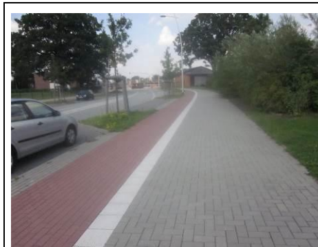
Ulzburger Straße: Blindenleitstreifen als Abgrenzung zum Fußweg
