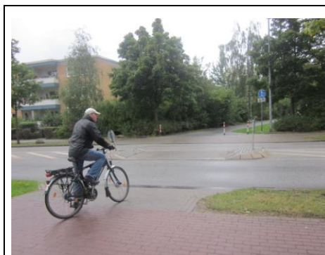
Querungsstelle Marommer Straße / Copernicusstraße: zu schmale Mittelinsel
