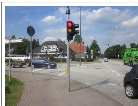
Kreuzung Ulzburger Straße/ Quickborner Straße: zu kurze Grünzeit
