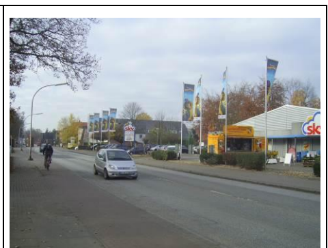
Segeberger Chaussee, Höhe Sky / REWE - Markt: fehlende Querungsanlage
