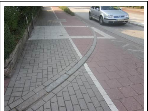
Ulzburger Straße: Blindenleitstreifen im Aufstellbereich
