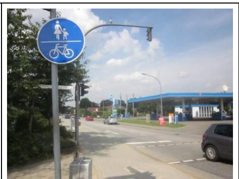
Ulzburger Straße: zu geringe Breite des gemeinsamen Geh- und Radweges im Zweirichtungsverkehr
