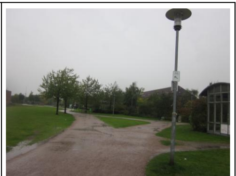
Wegeverbindung Moorbek-Park: Pfützenbildung auf wassergebundener Decke
