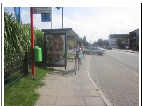
Ulzburger Straße: Radverkehrsführung im Wartebereich
