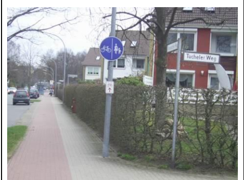
Stonsdorfer Straße: Fußwegbereich zu schmal
