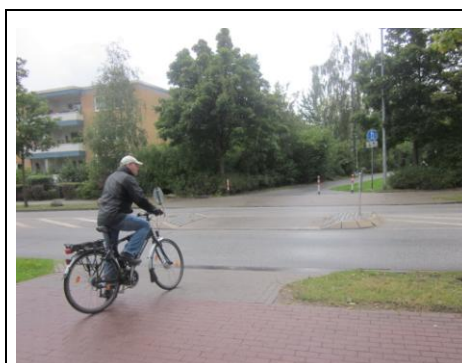
Querungsstelle Marommer Straße / Copernicusstraße: zu schmale Mittelinsel
