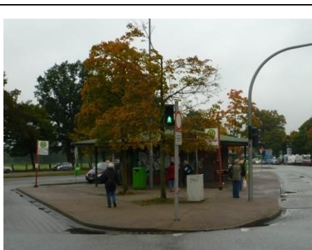
ZOB Glashütte: unwirtlicher Aufenthaltsbereich
