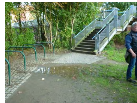
Pfützenbildung vor dem Treppenzugang im Bereich des Amtsgerichts, mangelhafte Beleuchtung
