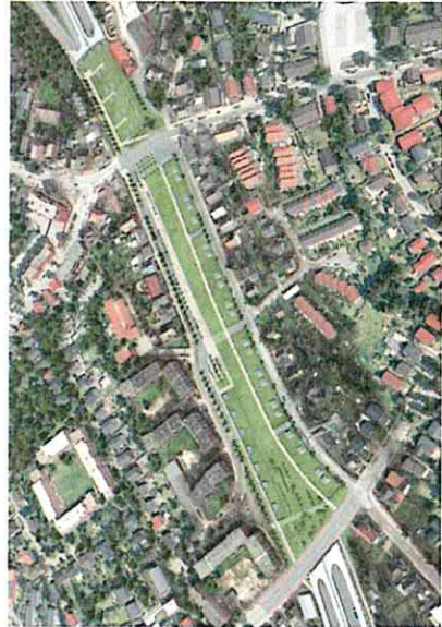
Das Ziel vor Augen. Der fertige Lärmschutzdeckel in Schnelsen.
