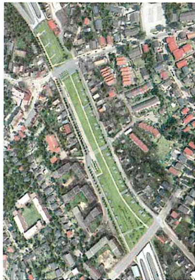
Das Ziel vor Augen. Der fertige Lärmschutzdeckel in Schmelsern.
