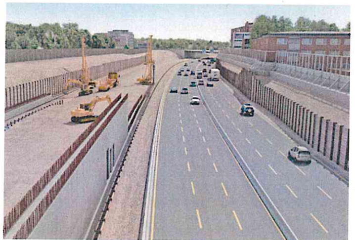
Abb. 5: Verlegung aller sechs Fahrstreifen auf die Fahrbahn Richtung Hannover.
