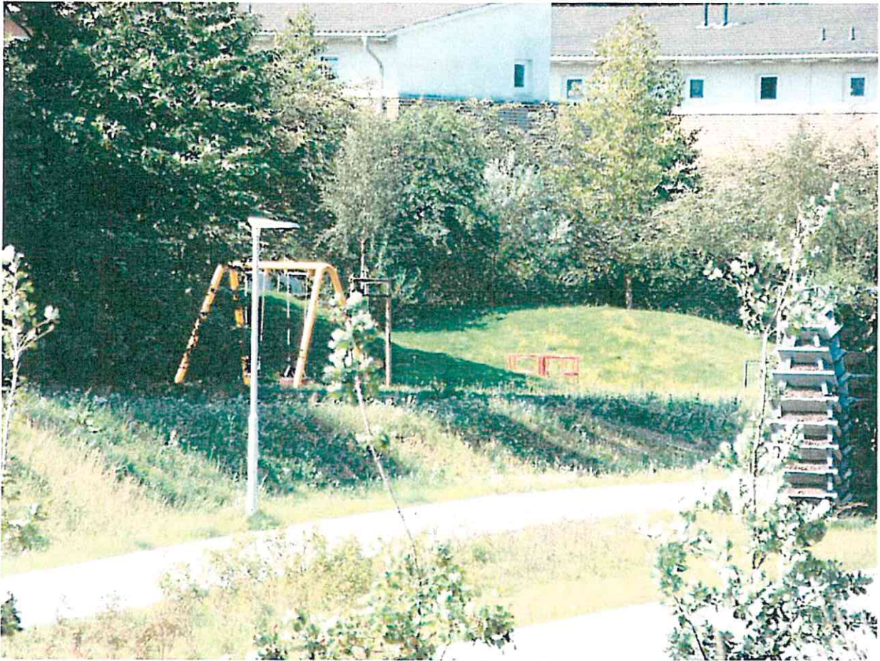
Foto_2: Blick auf das fehlende Stück Lärmschutzwand
