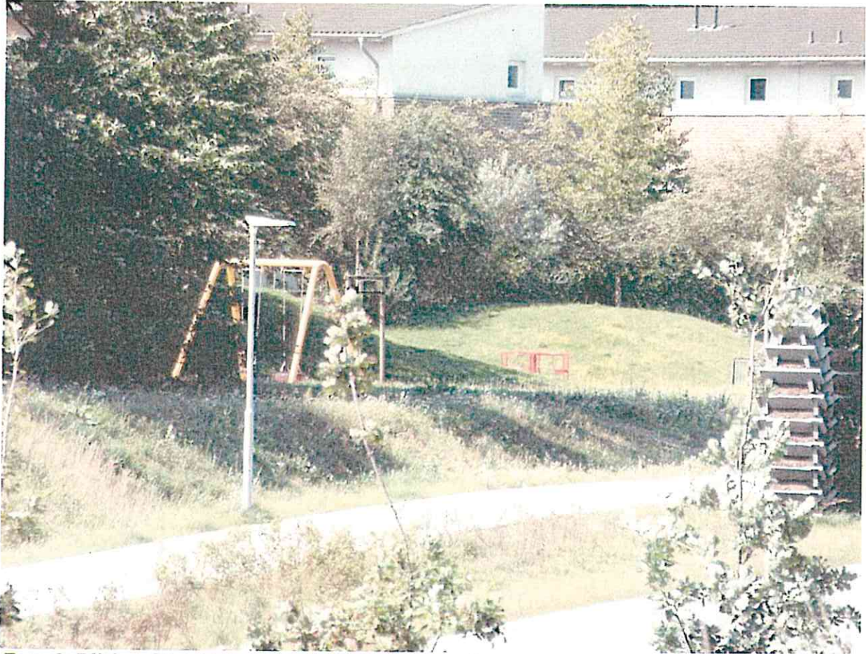
Foto_2: Blick auf das fehlende Stück Lärmschutzwand
