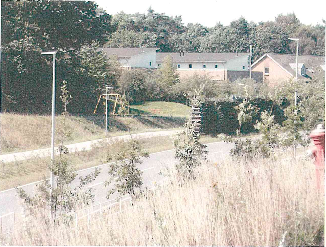
Foto_1: Blick von der Brücke auf das fehlende Stück Lärmschutzwand
