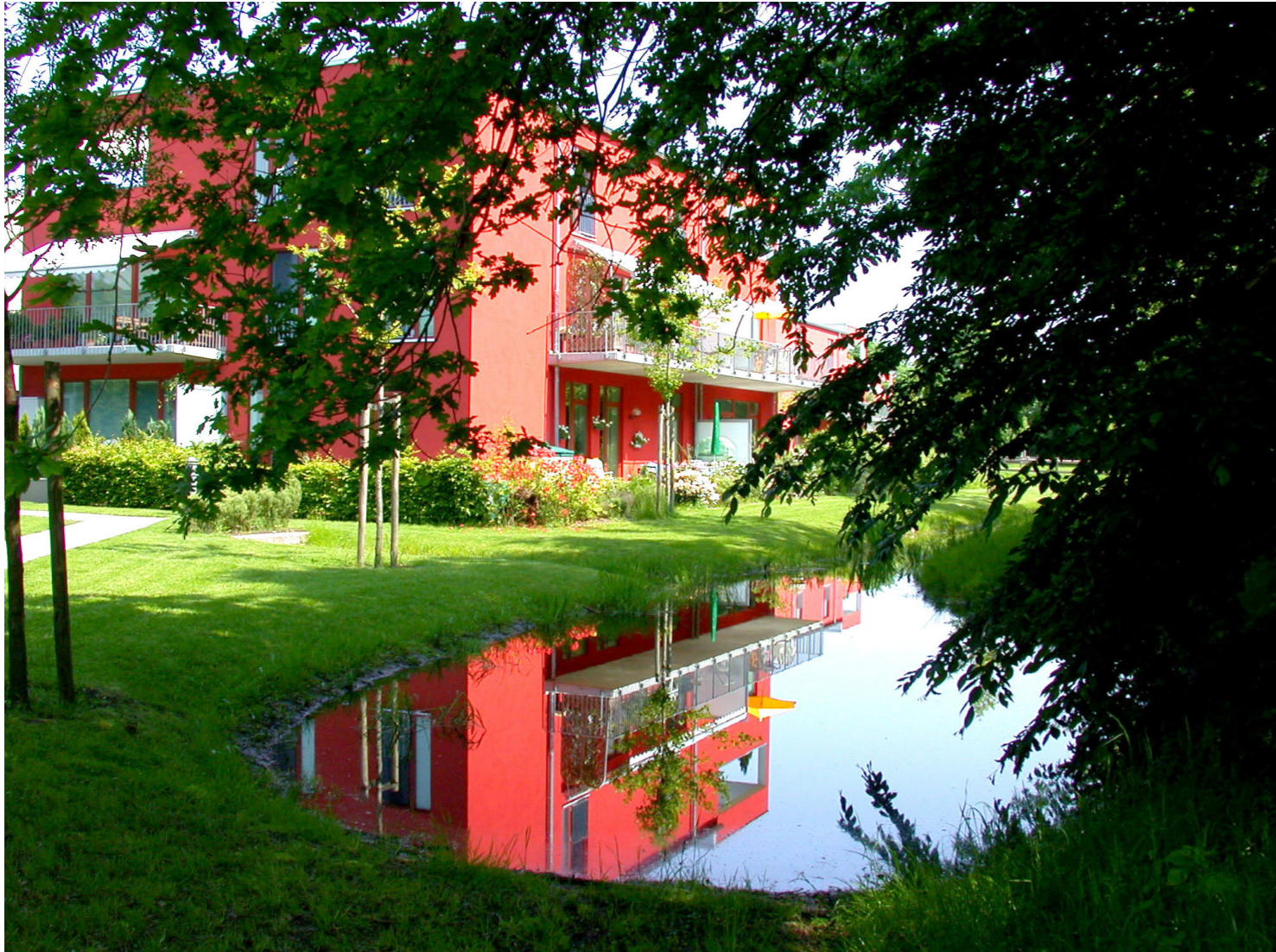
Wohnquartier Poppenbüttel Regenwasserrückhaltung
