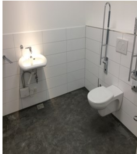
Behinderten WC Fertigstellung
