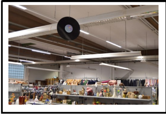
Alte Neon-Leuchten unter neuen LED
