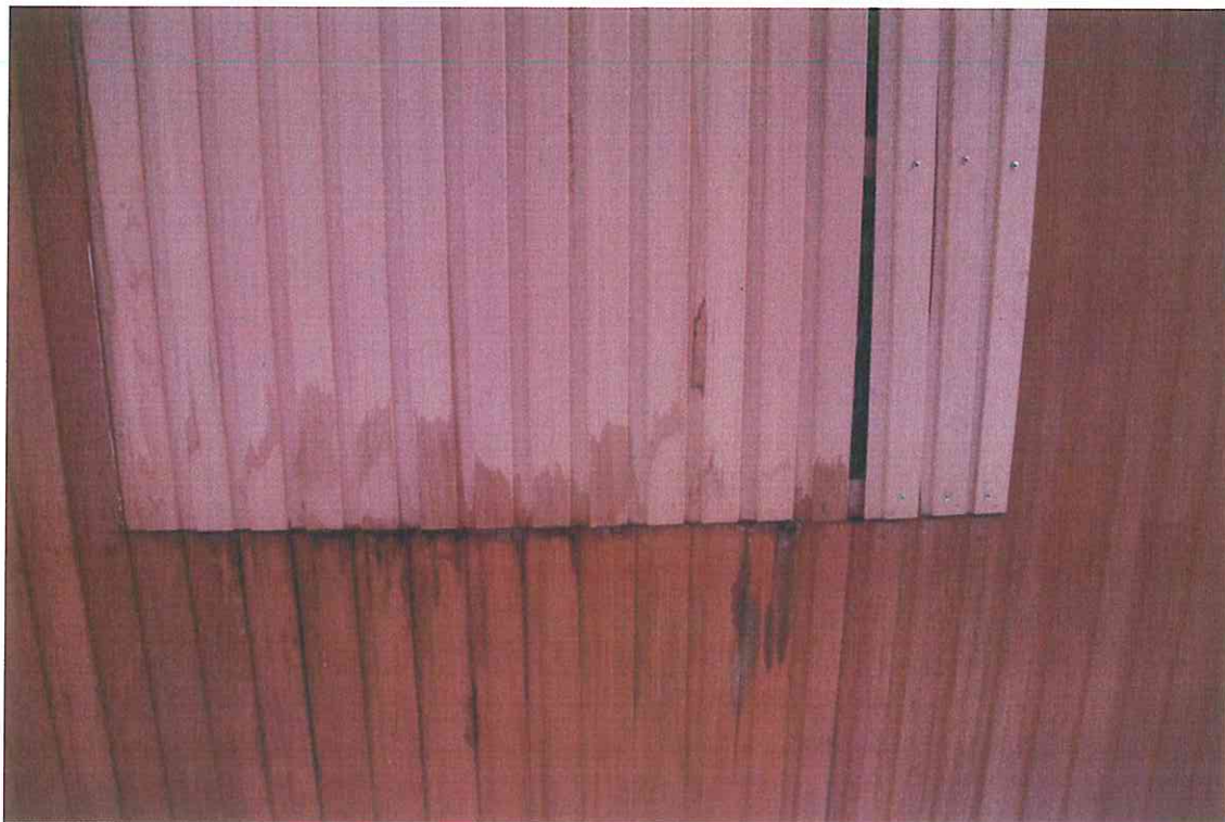
Foto 10 Wasserschaden Decke
