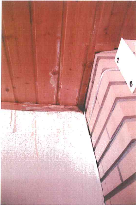
Foto 16 Wasserschaden Decke
