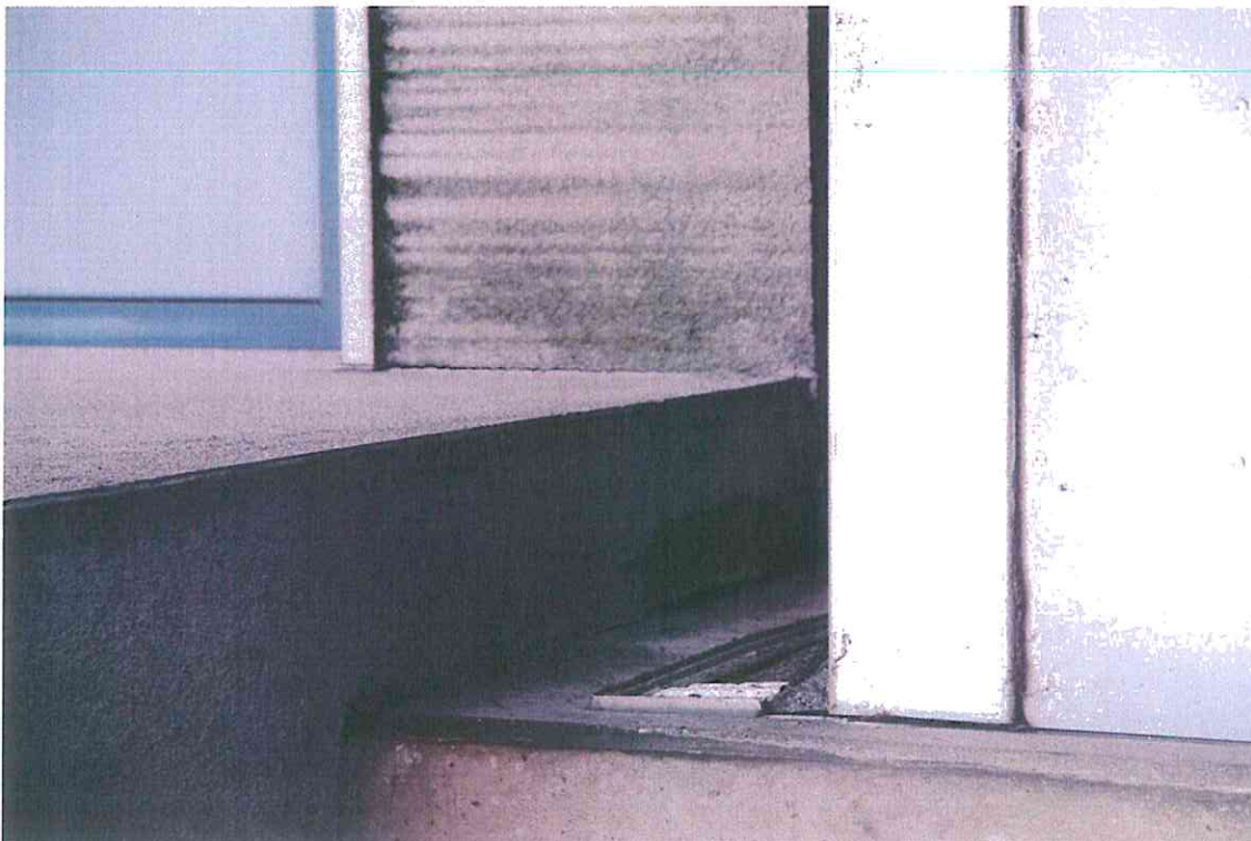
Foto 21 undichte Fenster-/Dachabschlüsse
