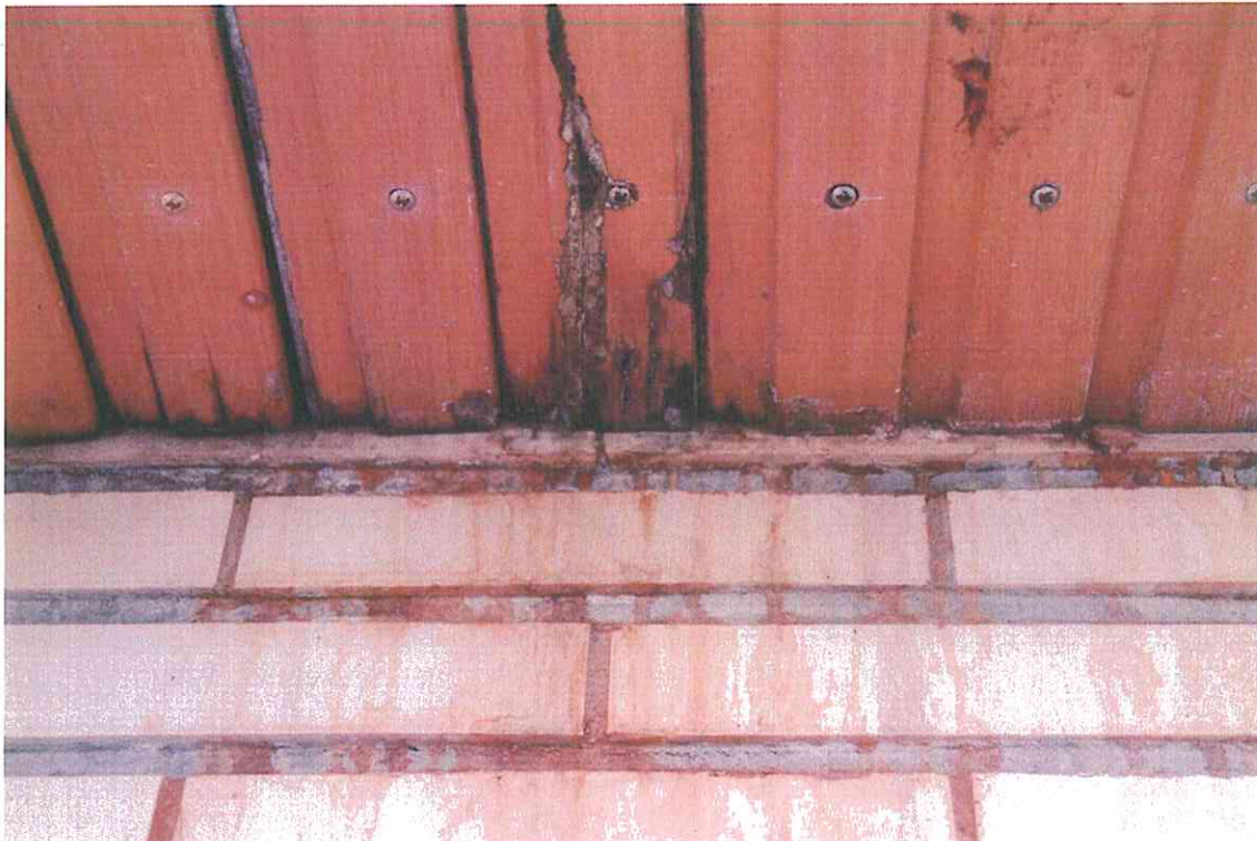
Foto 6 Nahaufnahme aufgeweichte Täfelung
