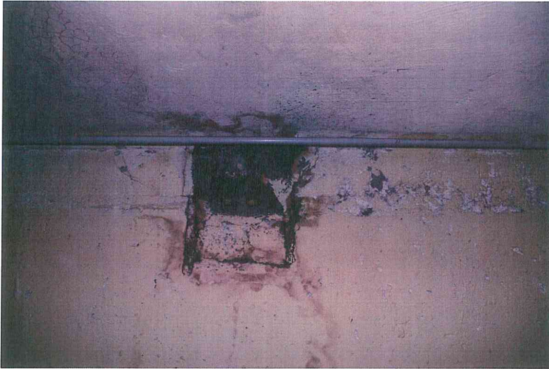
Foto 28 Wasserschaden
