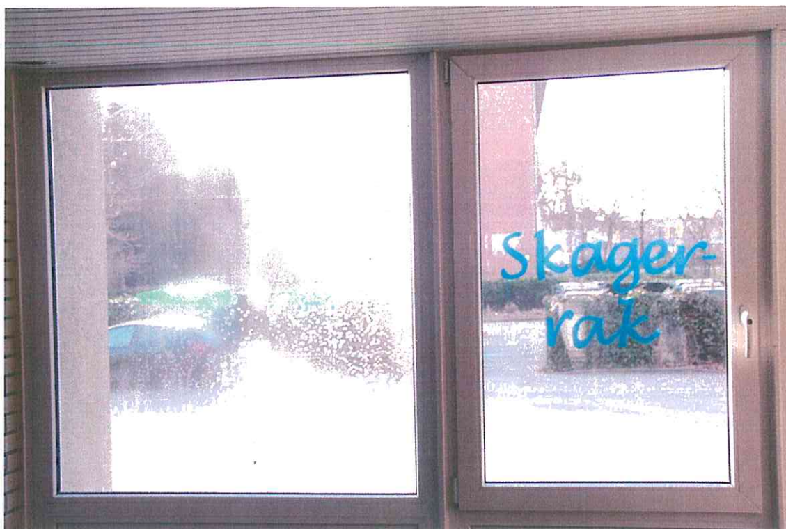
Foto 19 undichte Fenster
