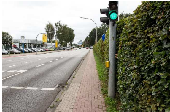
Abbildung 1: Gemeinsamer Geh- und Radweg in zu geringer Breite an der Niendorfer Straße (Foto: Philipp Böhme)
