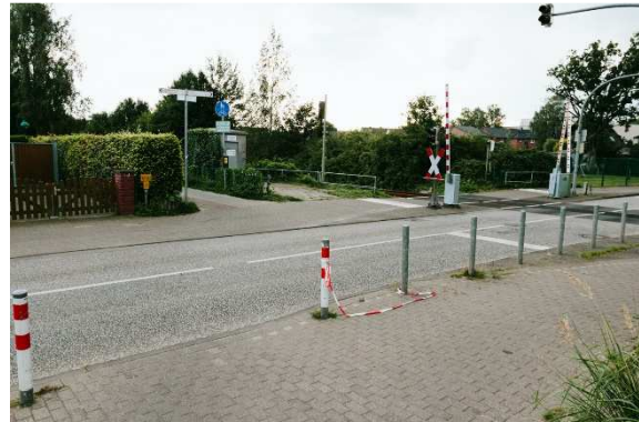
Blickrichtung Süden auf Querung Waldstraße
