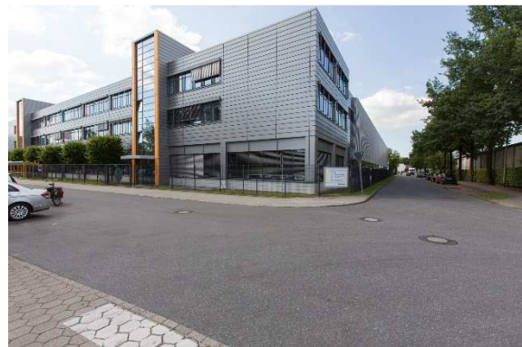
Blick auf Knoten Industriestraße/Erlengang (Blickrichtung Nord)
