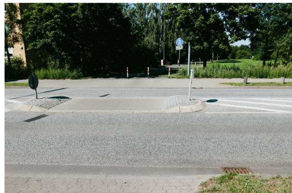
Blick Richtung Norden
