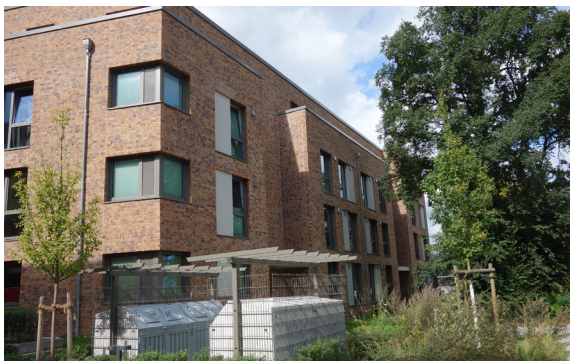
Beispiel für Bebauung (Ulzburger Straße)
