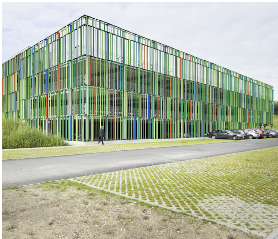
Beispiel für eine Quartiersgarage
