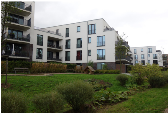
Beispiel für Bebauung mit Freiraumgestaltung (Garstedter Dreieck)
