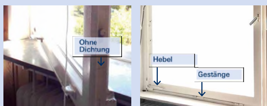
Bild 2/3: Fenster mit Isolierglas, ohne Dichtung (typisches Merkmal Hebelfunktion mit Gestänge)
