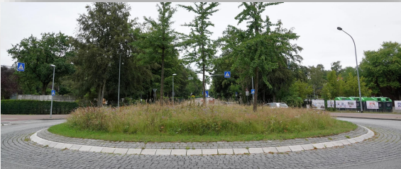
Kreisverkehr Langenharmer Weg
