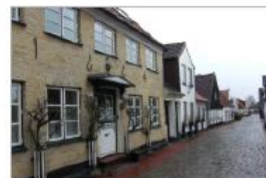
Holm - gelbe Sichtmauerwerksfassaden
