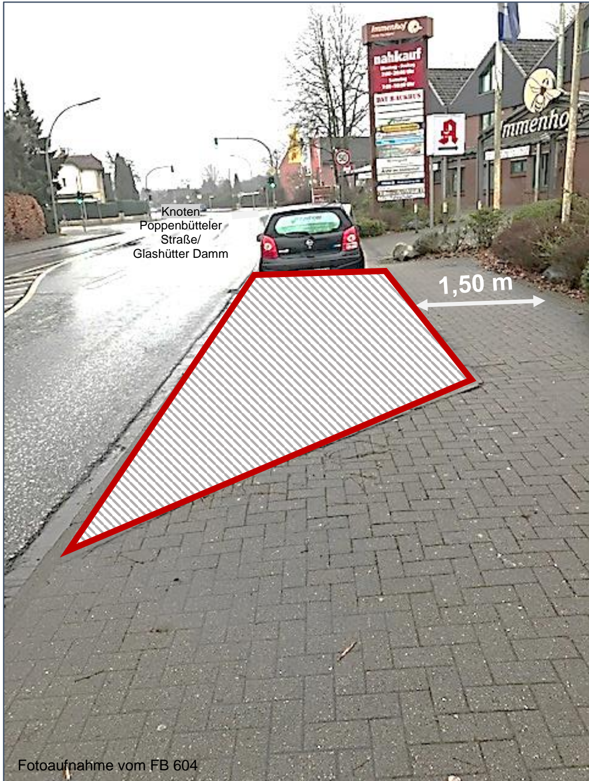
Parkbucht an der Poppenbütteler Straße, Höhe EKZ Immenhof hier: Umbau der Parkfläche zur Gehwegfläche
