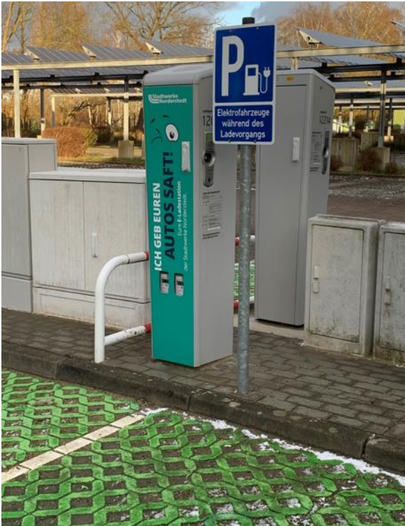
Foto 1: Ladestation am Arriba Freizeitbad (Barrieren durch Schaltkästen, Bügel, Schilder)
