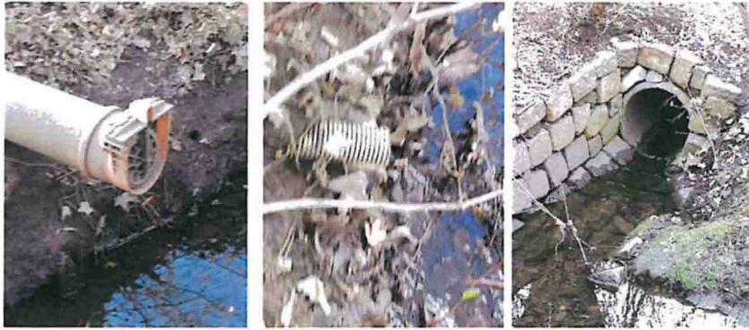
Bilder 3-5: Drei Einleitungen, alle sind Ableitungen des Schulgeländes
