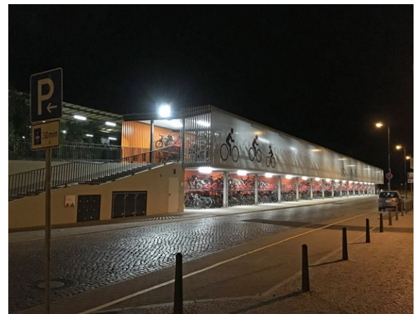
Gut beleuchtetes Fahrradparkhaus
