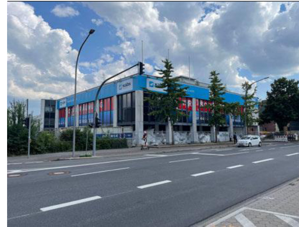
ex Kabs/Projektvorhaben Berliner Allee
