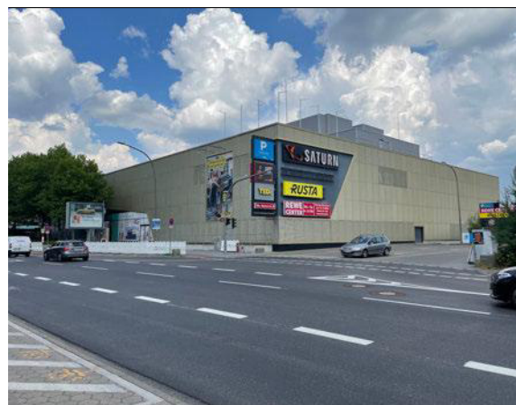
Einfahrt Parkdeck De-Gasperi-Passage
