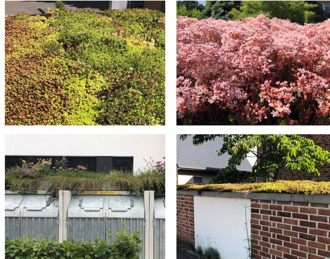
Auch kleine Gründächer speichern bereits eine große Menge Regenwasser, entlasten dadurch die Kanalisation und kühlen die Umgebungstemperatur.
