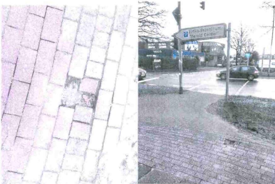
Gleiches gilt auch für den Fußweg an dieser Stelle, wo entweder die Gehwegplatten fehlen bzw. uneben sind.
