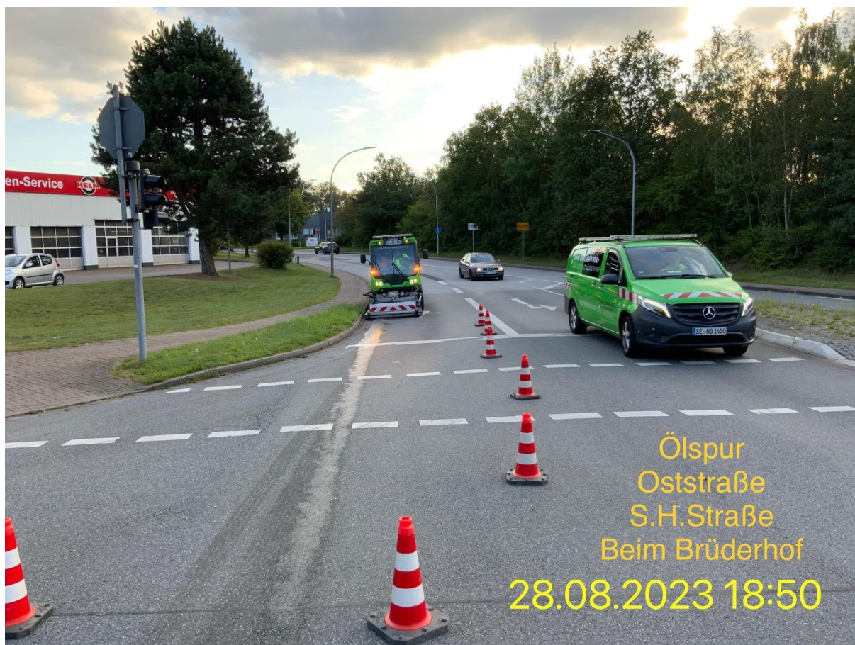
Ölspur auf der Fahrbahn. Die fachgerechte Beseitigung nach dem DWA- Merkblatt übernimmt die Stadtentwässerung mit der Sielbereitschaft.
