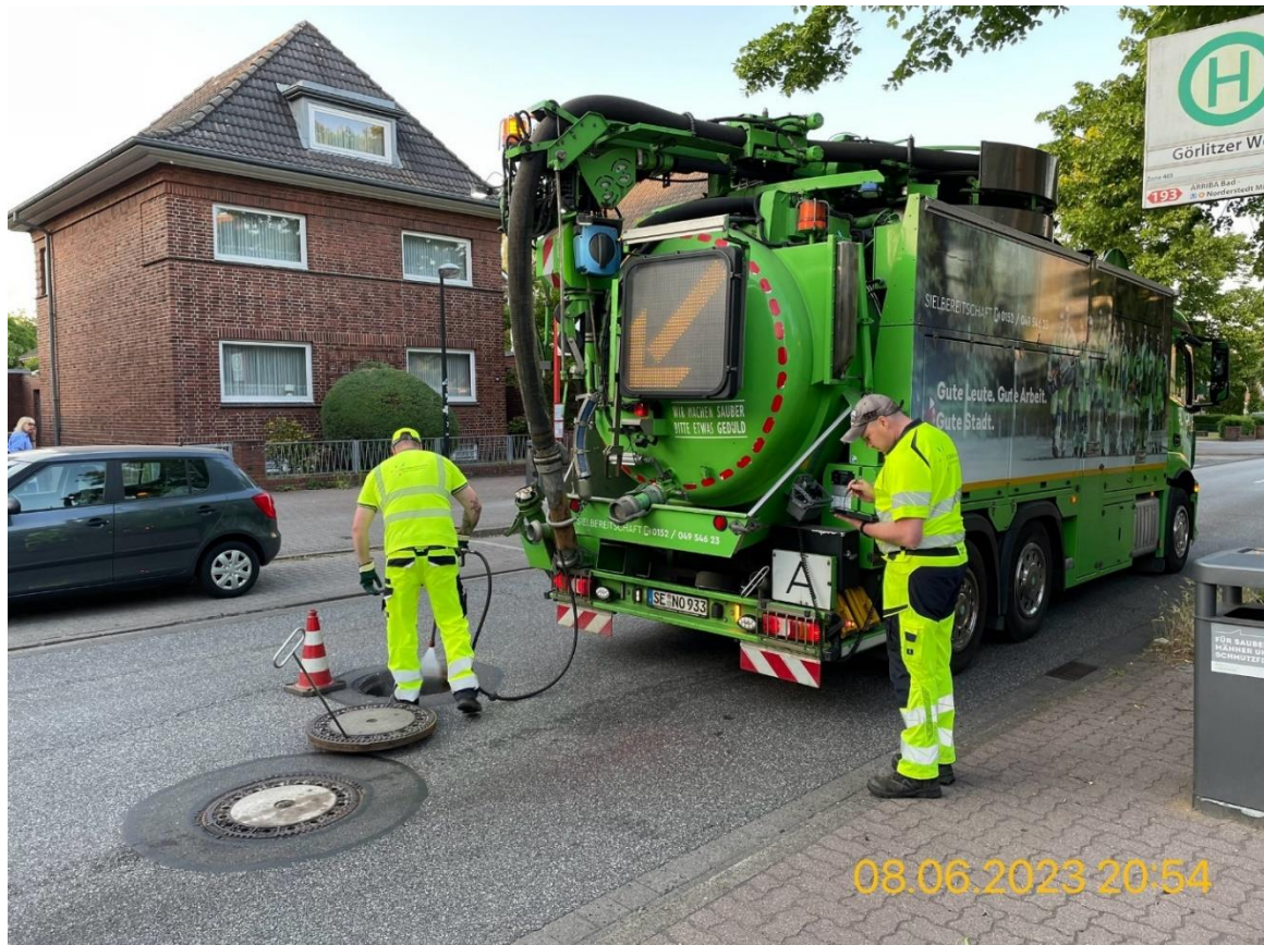
Erste Eingaben mit der neuen Soft- und Hardware zur Dokumentation der Unterhaltungsreinigung am Schmutzwasserkanal in der Ochsenzoller Straße
