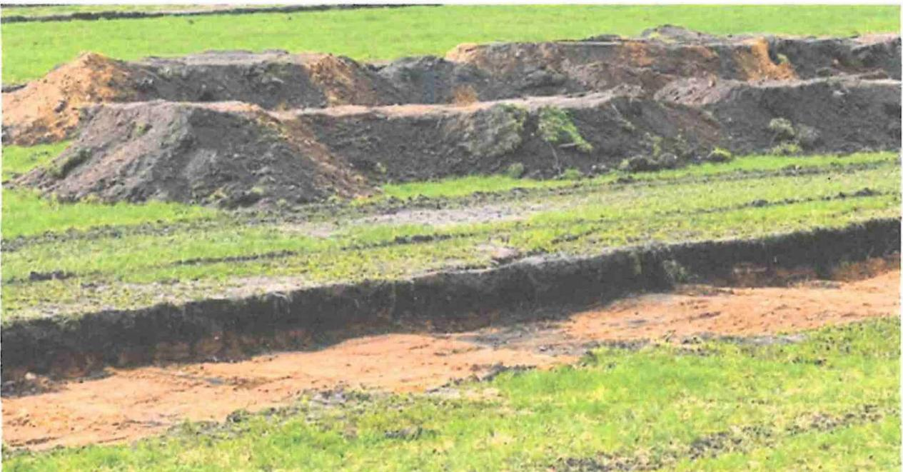
**Foto 2: Baumaßnahme an der Harckeshyde gegenüber der Wertstoffinsel, Bodenaushub bis unterhalb des Mutterbodenhorizonts (Quelle: Pranzas, 02. März 2024)**
