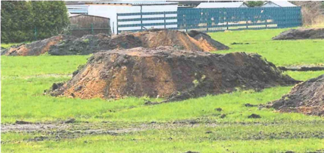
**Foto 1: Baustelle an der Harckeshyde gegenüber der Wertstoffinsel, Vermischung von Mutter mit Unterboden**
