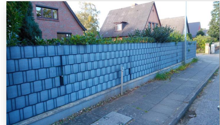
Beispiel einer geschlossenen Einfriedung
