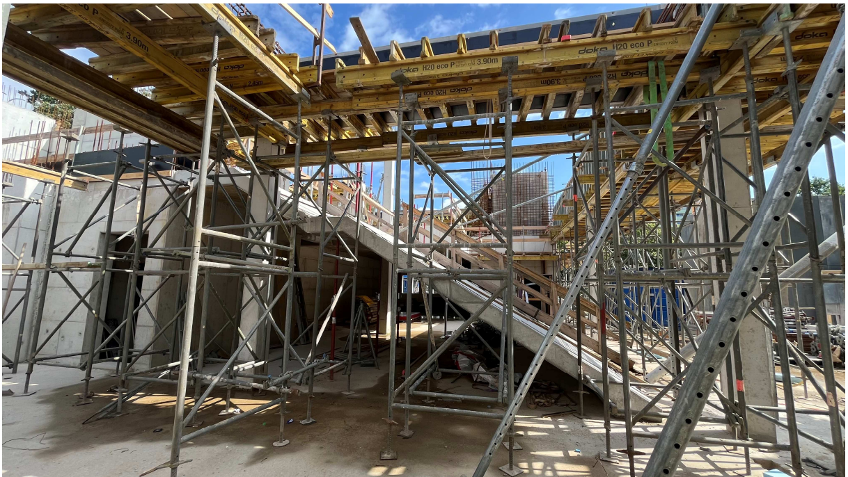
Bildungstreppe im Erdgeschoss mit Deckenschalung
