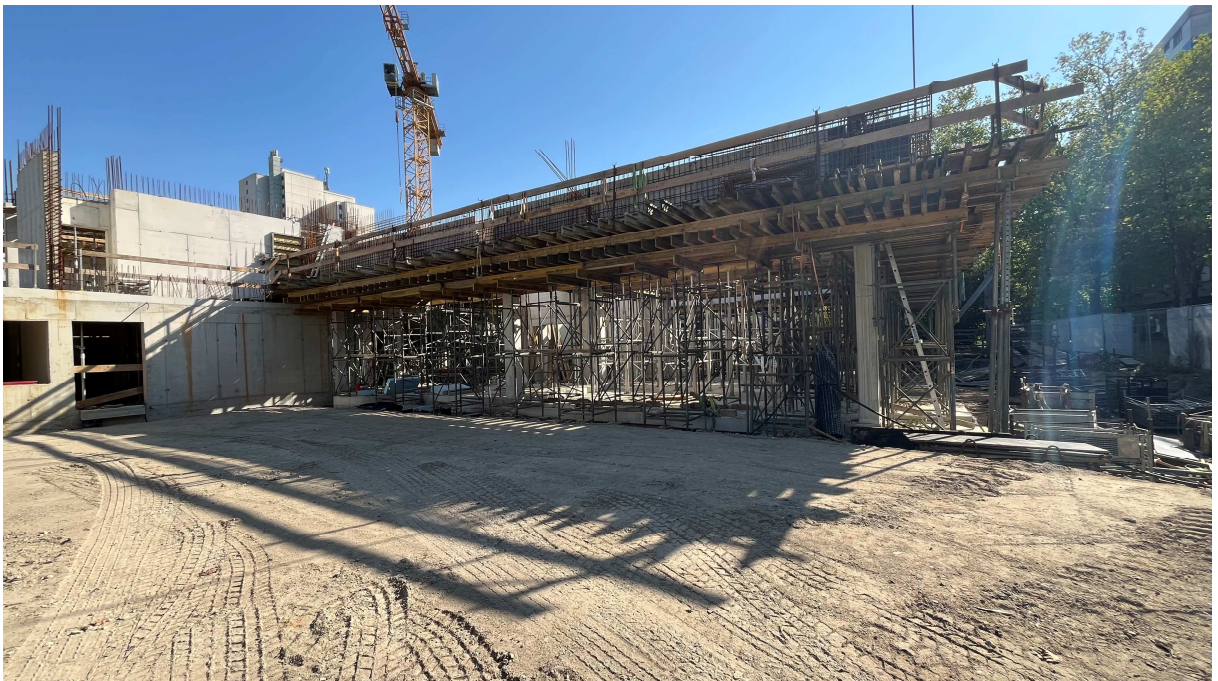
Herstellung der Decke über dem Veranstaltungsraum im Bauteil West
