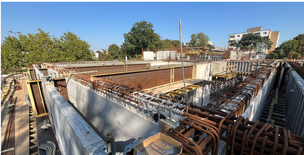
Einbau der Stahlträger über dem Veranstaltungsraum
